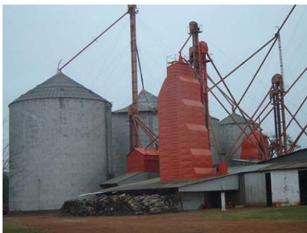
Foto 7: Uso de leña para silos
