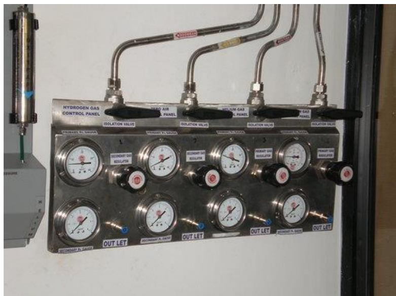
Figura 42. Panel de distribución de gases.
