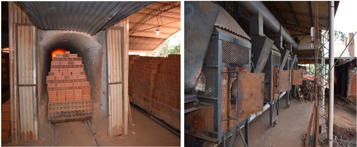
Foto 10 – Hornos de Túnel y Móvil Utilizados por Industria de Cerámica en Bella Vista
