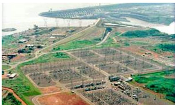
Sin embargo, de estas 4 líneas de 50 Hz, solamente dos están conectadas a la barra de 500 kV mientras que las otras dos se llevan directamente hacia la Estación Convertora de FURNAS, situada en territorio brasileño y que permite adaptar la tensión de 50 Hz a 60 Hz. Estas dos líneas tienen una longitud total de 11 km.
